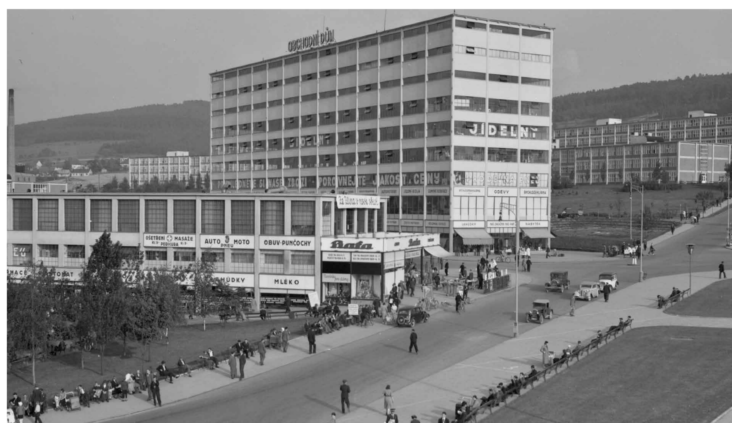
Obchodní dům Baťa na náměstí Práce a budova tržnice, 1937, autor Josef Vaňhara. (SOkA Zlín, obálka č. 5376, poř. č. 4.)
