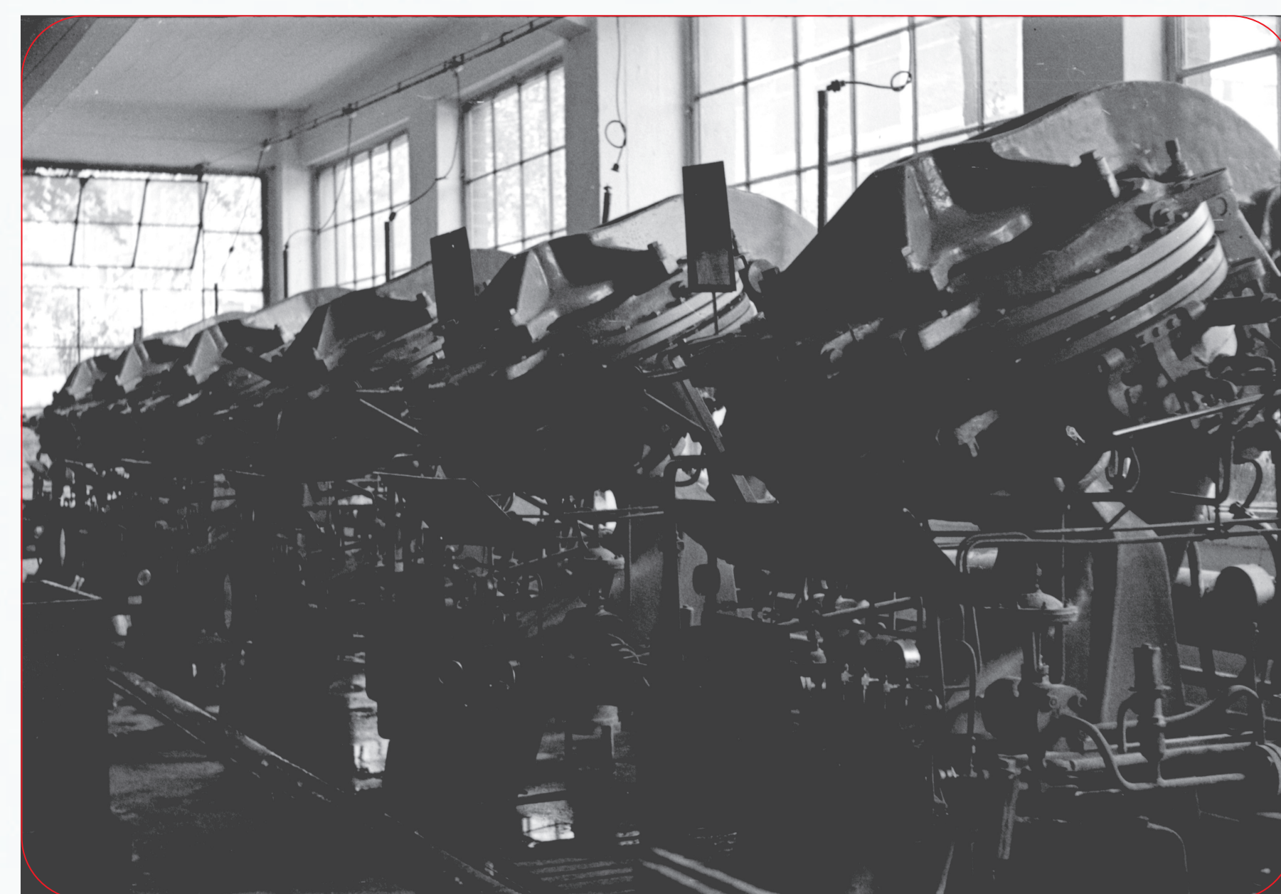
Baťovy závody – vulkanizační lisy v pneumatikárně, 1937. (SOka Zlín, obálka č. 4322, poř. č. 1.)
